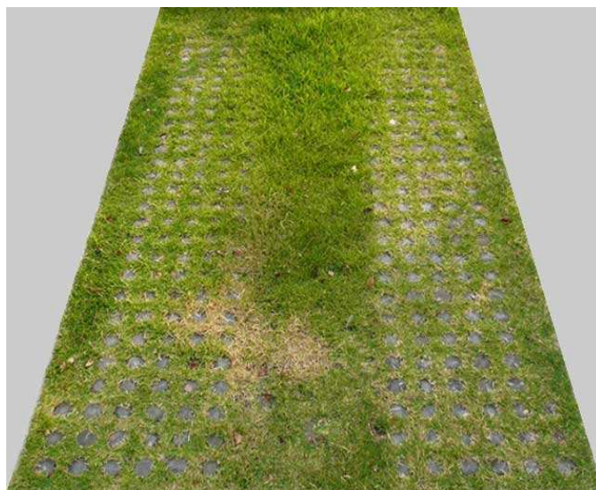
▲兵庫県庁敷地内 施工後3年経過
