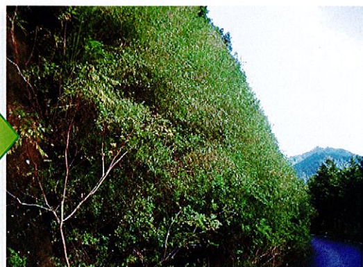
▲ウッド筋工+和歌山ソイル (ローカル・リサイクル吹付工)
