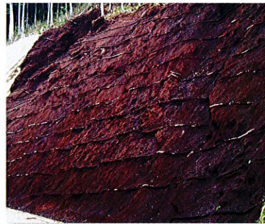
▲ウッド筋工+和歌山ソイル (ローカル・リサイクル吹付工)
