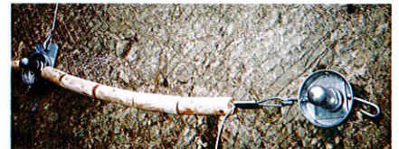
ロックボルト頭部処理
