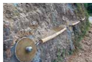
ウッド筋工の設置
