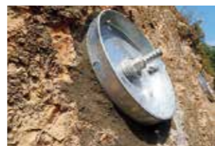
支圧板(丸ボックス)の設置
