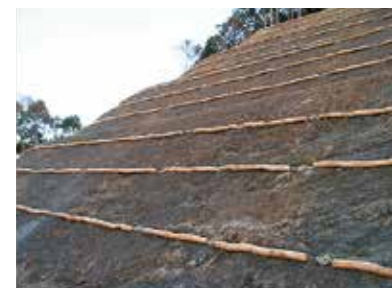
ウッド筋工設置状況
