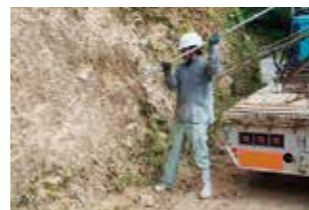
鉄筋挿入工／挿入
