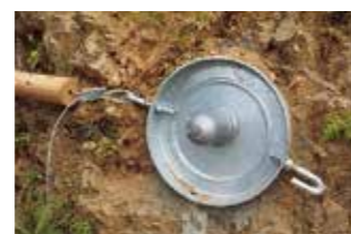
頭部処理工／ナットの締め付け・キャップの取付
