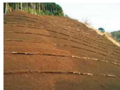
ローカルリサイクル吹付工(和歌山ソイル)施工後
