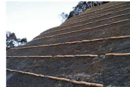
筋工設置状況
