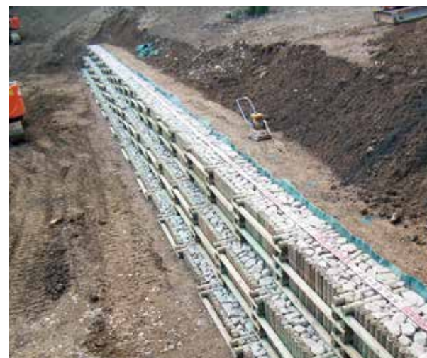
施工例／栗石完了
