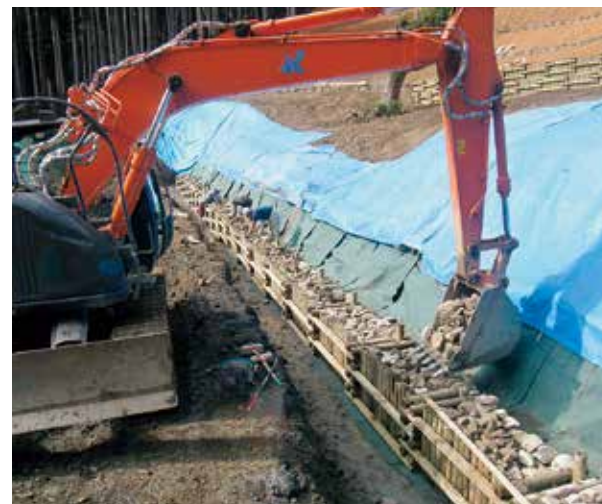
施工例／栗石投入
