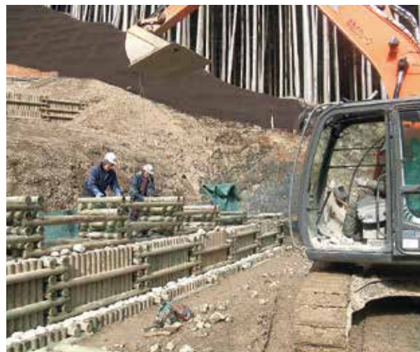
施工例／二重井桁枠・組立
