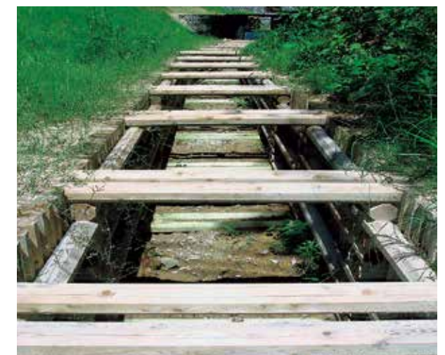
施工例／水路工(底施工なし)
