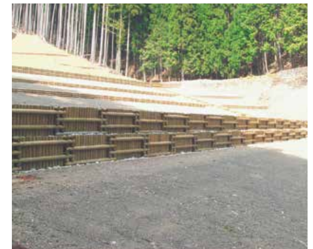
施工例／土留工
