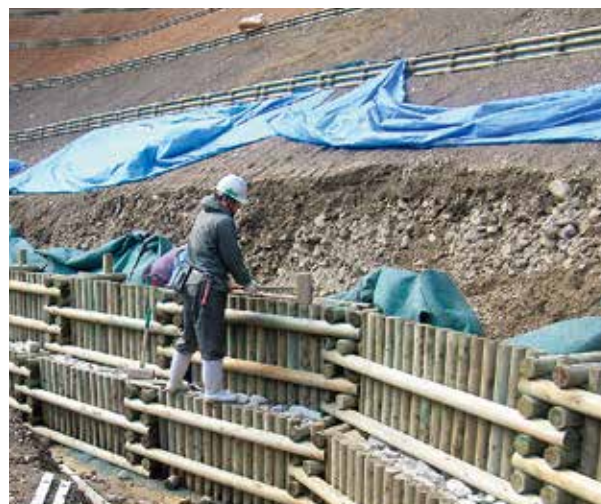
施工例／支柱打込み
