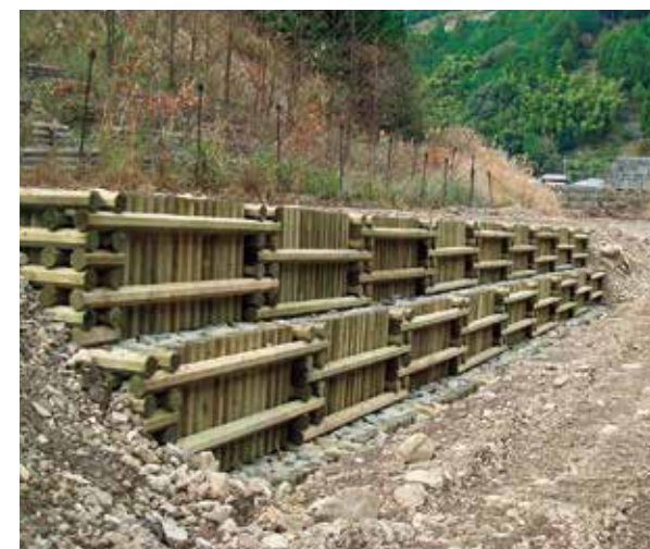
施工例／護岸工
