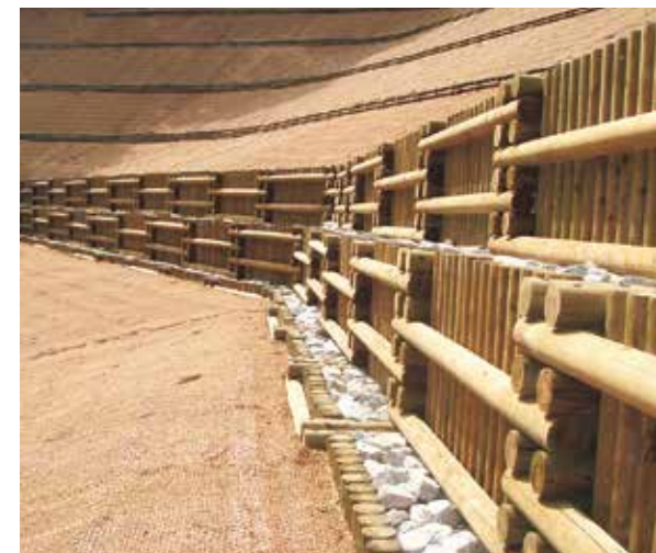
施工例／土留工
