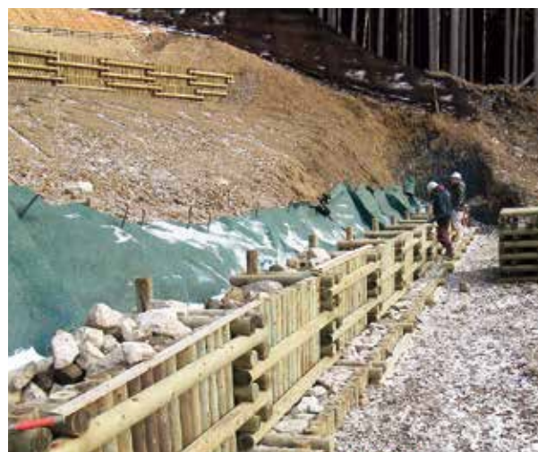
施工例／栗石敷詰
