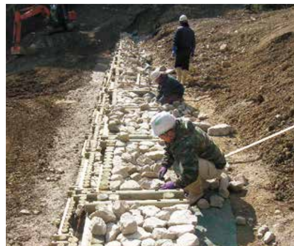
施工例／栗石敷詰
