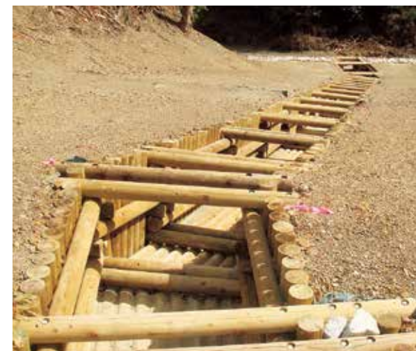
施工例／水路工
