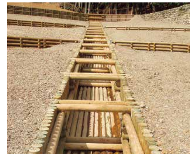
施工例／水路工
