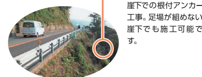
崖下での根付アンカーアンカーワーク。足場が組めない崖下でも施工可能です。
